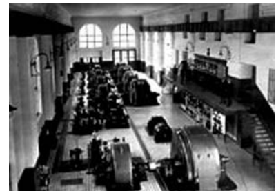
The generating hall of the Museu Hidroelèctric de Capdella. © mNACTEC
